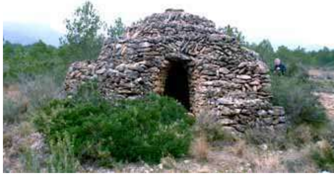
B4. Barraca en espiral . L'exterior d'aquesta barraca s'ha fet en espiral, de manera que es pot pujar fins dalt i treure la pedra que la corona superiorment, per tal de deixar pas al fum.
