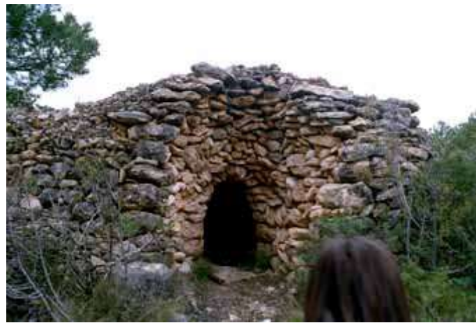
B9. Barraca del Miquel Terna . Crida l'atenció aquesta abertura rebaixada fins l'entrada, com en una capella.
