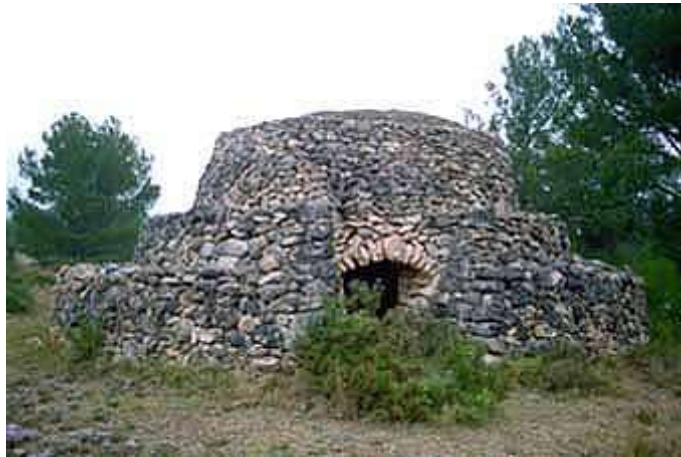
B11. Barraca del Jaume de la cota . Armoniosa de línies i de gran volum, fa 4,10 de diàmetre per 3,9 m d'alçada, es considerada el millor exemplar de terres tarragonines. Té quatre cocons coronats amb arc, i l'entrada arcada a les dues bandes. La coberta està ben protegida amb terra i herba.
