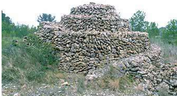
Vista posterior on s'observa la clau que tanca la cúpula.
